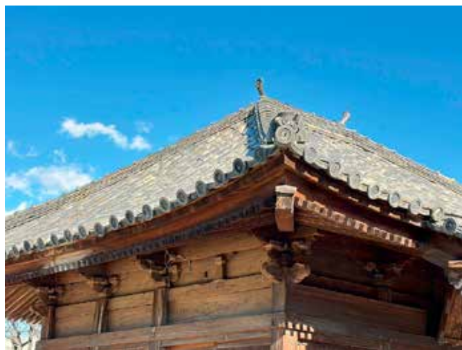
▲ 振れ隅にして屋根を美しく見せる
