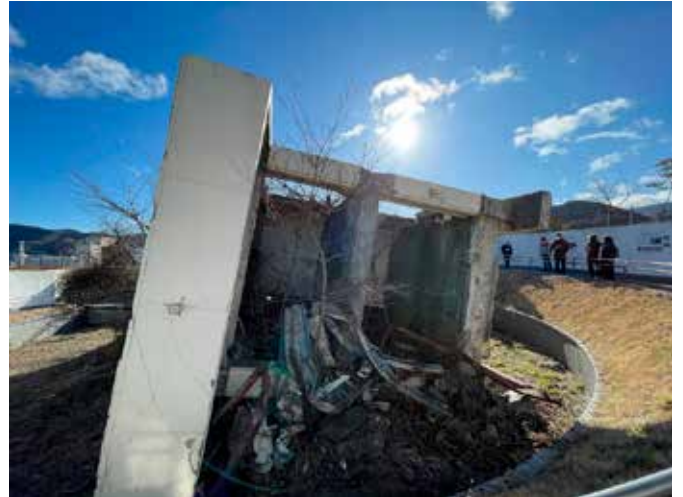
▲ 女川交番被災状況
