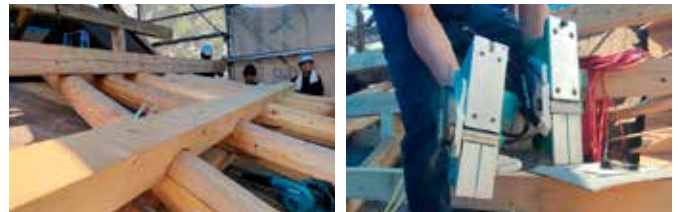
▲丸太から作り上げた桔木 ▲左側:丸みをつけた自作の道具
