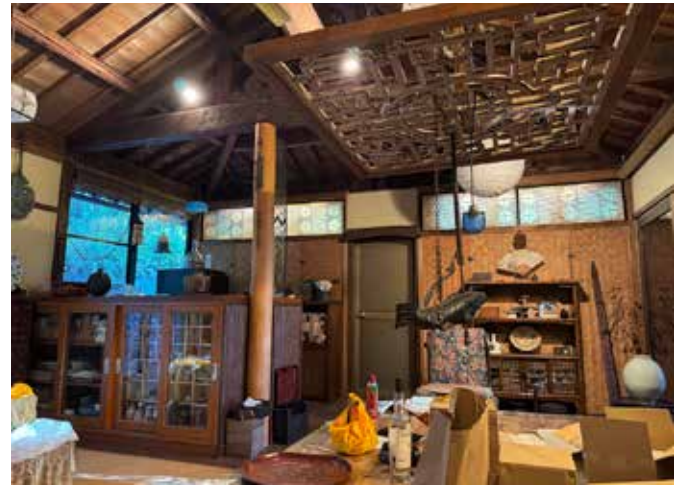
▲食事室 小屋組が現しとなっている
