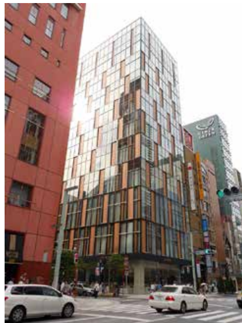
▲東京某ビル外観
