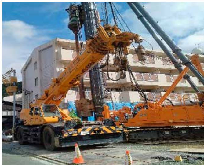
▲ 現在進行中の八幡浜市の工事現場
