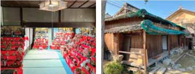
しかし建物の状態はよいとは言えず、柱の傾きも顕著で土葺の瓦もずれて落ちかかっているのをネットで留めているという状況で補修は一時を争う状況でした。
