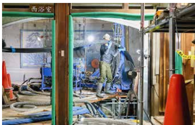
▲アースアンカー挿入状況（神の湯浴室）
