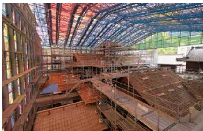
▲後期工事の瓦解体状況
