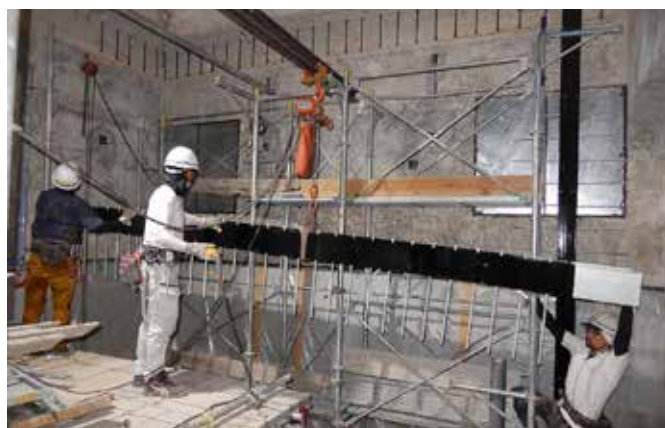
▲鉄骨搬入（神の湯浴室）
