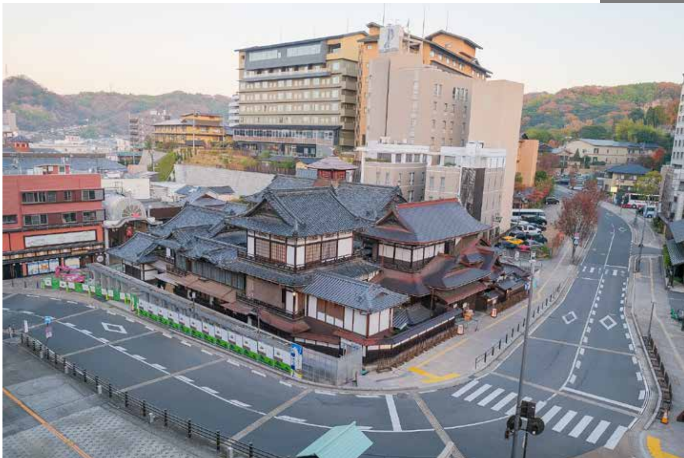
▲ 素屋根解体後の道後温泉本館
