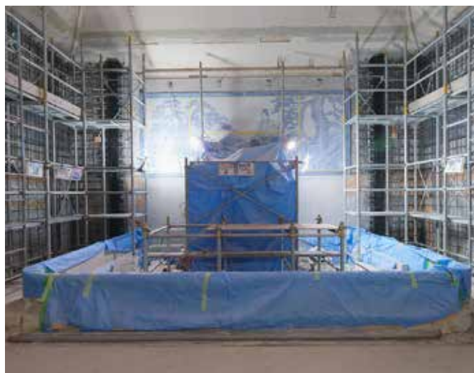
▲構造補強（神の湯浴室）
