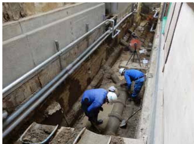
▲中央廊下掘削状況
