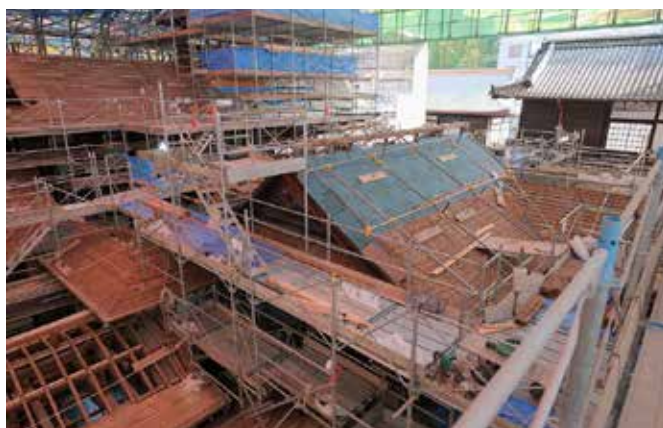
▲防水シートと杉皮葺（南棟）
