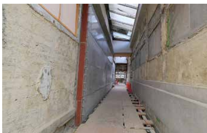
▲中央廊下側への構造補強
