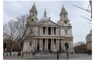
▲セントポール寺院
