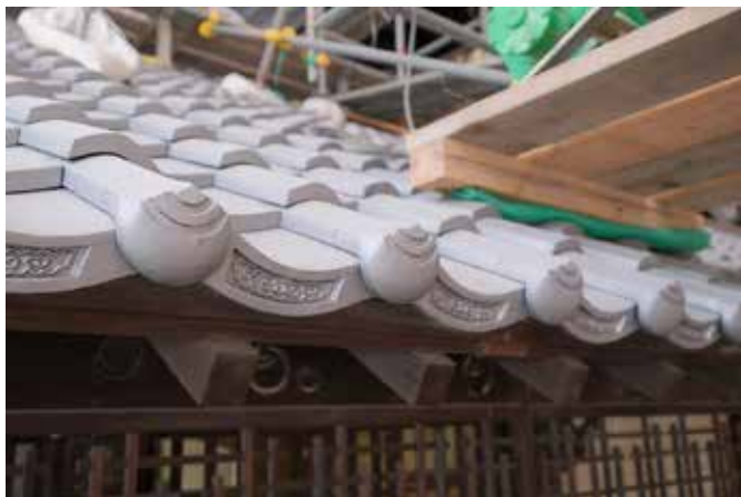
▲修理後の瓦（神の湯本館）
