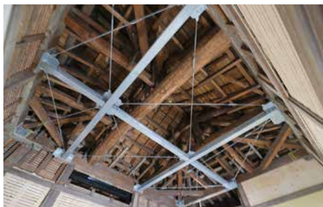
▲天井裏の構造補強（玄関棟南側）
