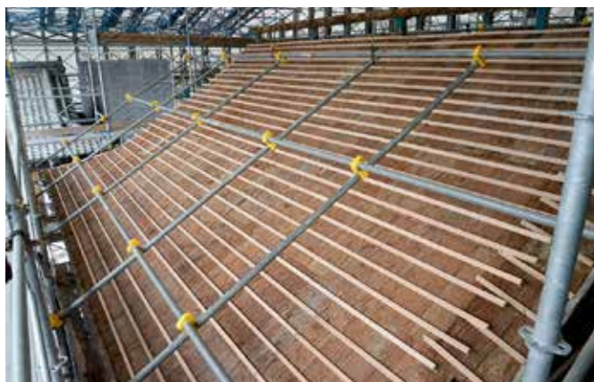
▲屋根の棧木（南棟）
