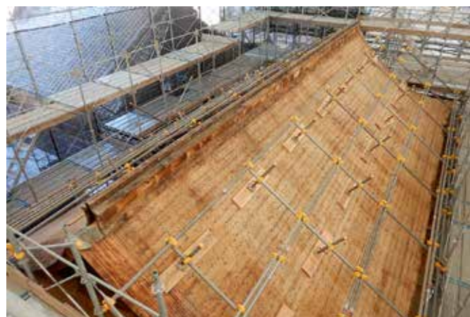
▲ 前期工事の銅板解体状況
