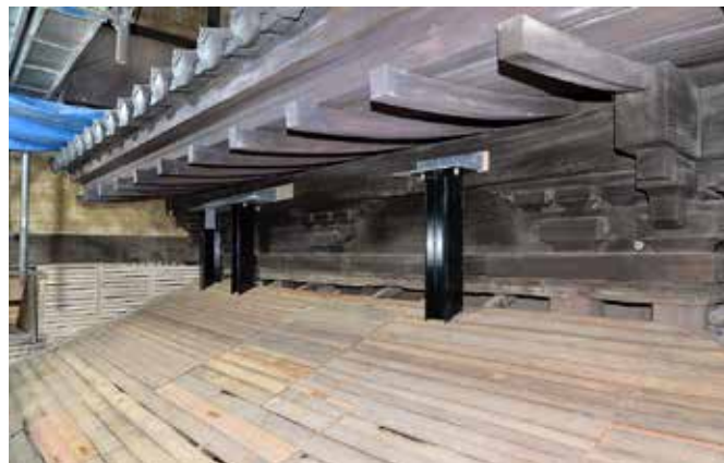
屋根貫通の構造補強 (玄関棟)
