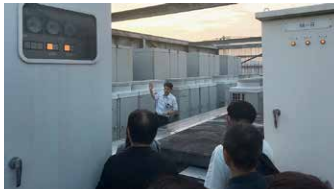
▲屋上設備スペースを見学
