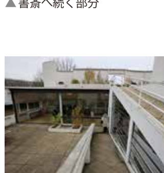
▲屋上庭園の目隠し壁
