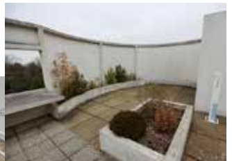
▲屋上庭園の目隠し壁
