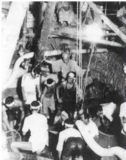
▲掘削の様子 大正3年頃（提供：道後温泉事務所）
