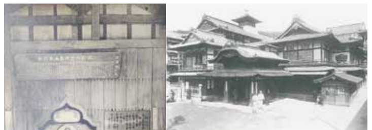
▲写真② 大正13年改築の養生湯西面(右)と玄関唐破風棟(昭和10年以降)
