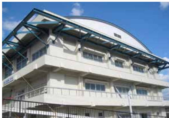
▲南宇和高校体育館耐震改修
