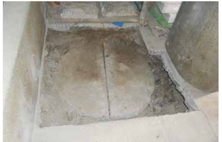
▲写真⑧ 発見された蓋とみられる円形で二分割の石板
