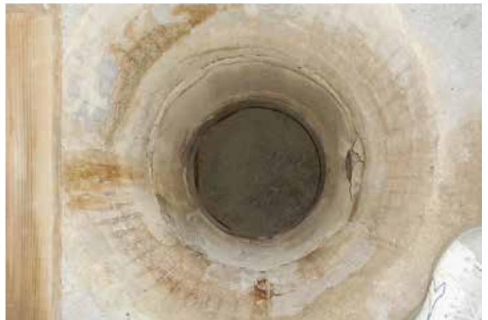
▲写真⑩ 源泉跡調査1 真上より見る
