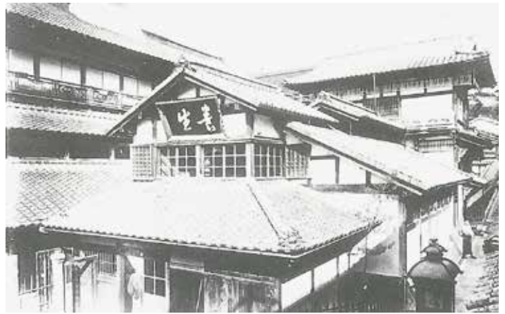
▲写真① 明治25年改築の養生湯西面
