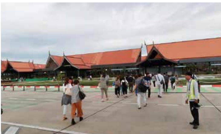
▲シュムリアップ空港ビル
