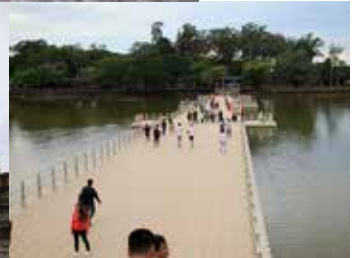
▲ 西側正面、仮設の浮橋
