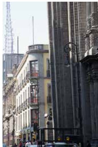
▲ 垂直でない建物の外壁
