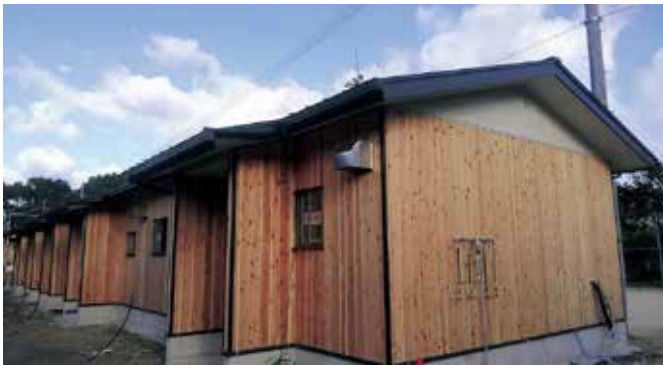
西予市野村町応急仮設木造住宅(著者撮影)
