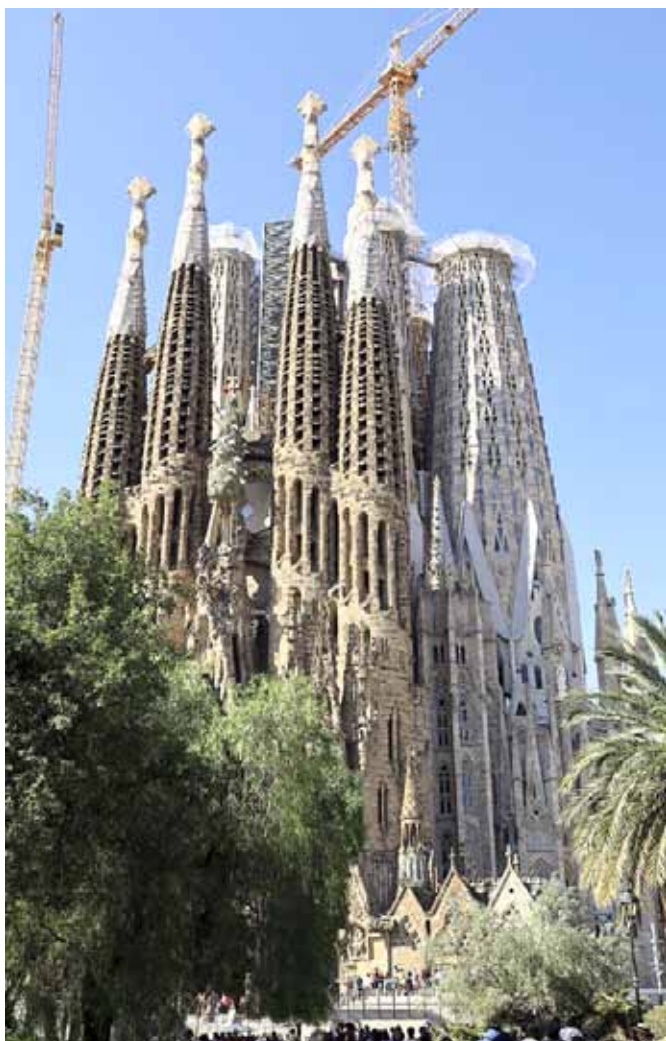
完成間近のマリアの塔(右側)
