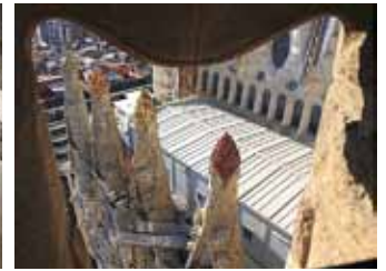
▲屋上での工事現場事務所
