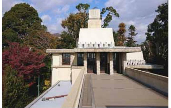
そして最後に訪れたのが兵庫県立美術館。私は数年前にも見学に訪れましたが、一番の特徴はRC造打ち放しで杉本実仕上げの数量が国内でも有数の建物であることです。巨大な建物の中でもエントランス部分の高い壁が杉本実仕上げとなっていますが、どこがコンクリート打ち継ぎなのかわからないくらい仕上げの美装がしっかりしており、設計者の意図を組んだ見事な施工である事を感じました。とかくコンクリート打ち放し仕上げは施工側の技術と生コンの品質、打設個所の構造によって極端に難易度が上がる仕上げだと思えますが、その上で杉本実仕上げは杉材の品質も加味されるため、大規模な施工数量の場合、資材の管理が何かと面倒な工法です。しかし打ち上がりの品質が良ければ、とてもきれいな仕上がりがだと思います。
