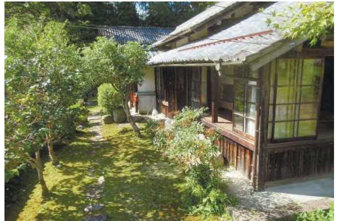
主屋南側の縁側
