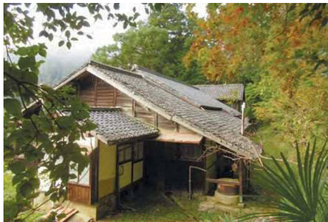
北東から見た屋根風景
