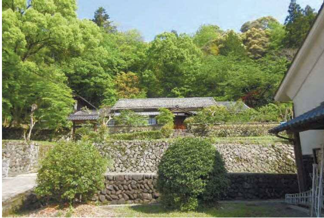
庄屋井谷家住宅全景
