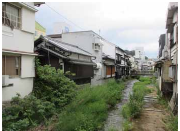
居住地跡を辰の川側から見る(宇和島市)
