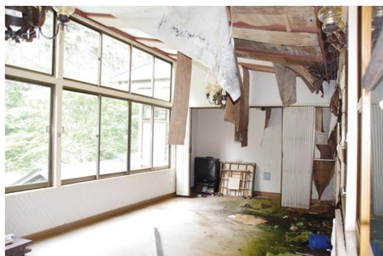
増改築された2階口ピー 屋根が内勾配で雨漏りが激しい。
