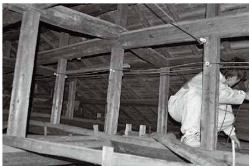
天井裏の小屋組の実測
