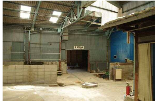
鉄骨造の屋根で覆われた中庭部分
