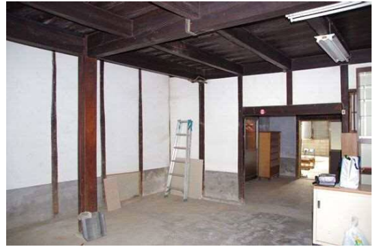
玄関から入ったところの通り土間
