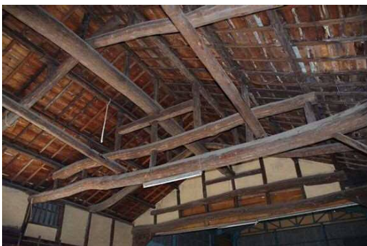
東側酒蔵の小屋組み 今治城の倉庫の材と伝えられている。
