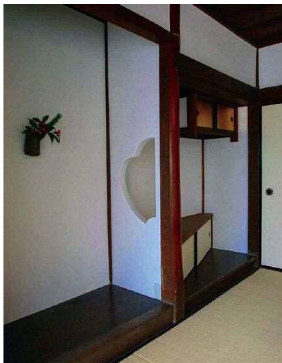
1階客間の押入から床の間の痕跡出現・復元する。
