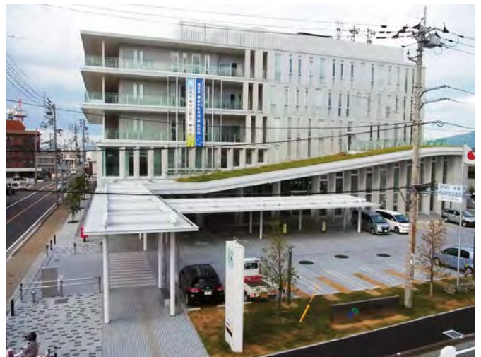
(伊予市庁舎の全景。棚田をイメージした屋上緑化が見えます)
