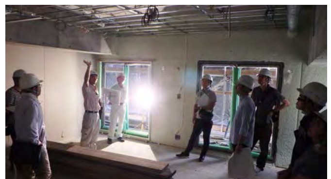
(吹き付けの断熱材や天井の下地等の現場を確認)
