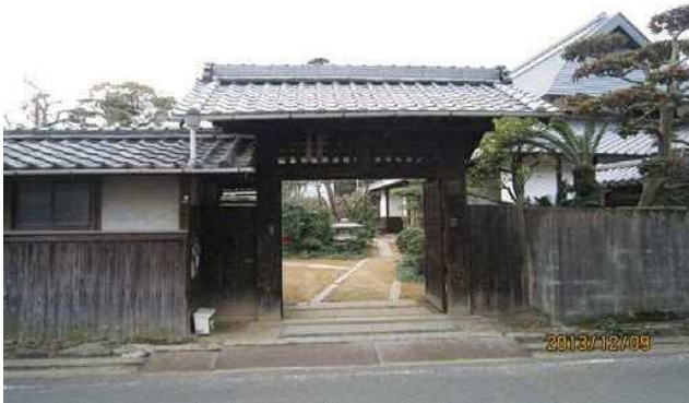
平成修理完成の長屋門
