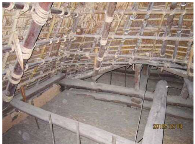
座敷の小屋組（座敷は後補の小屋組）
