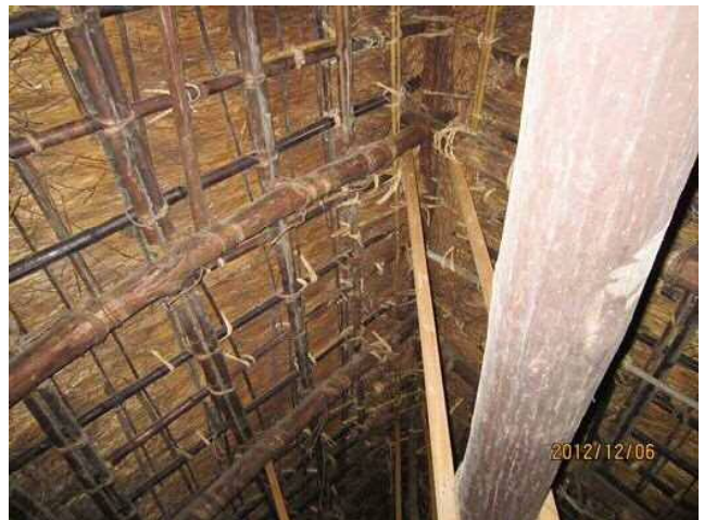
主屋の小屋組（茅葺きと構造）
