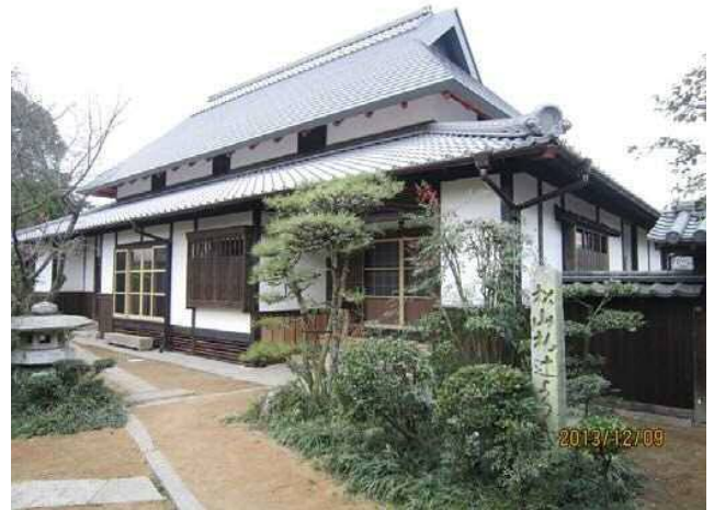
平成修理が完成・式台玄関を望む
