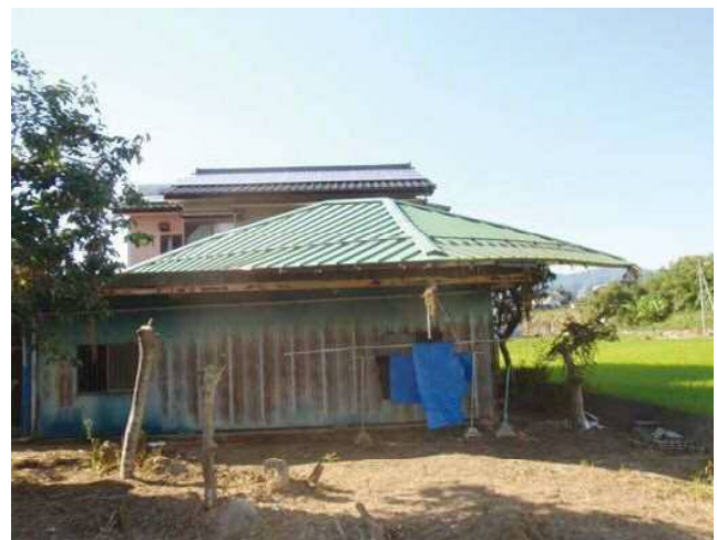
約200m 流れ付いた社務所の屋根部分
