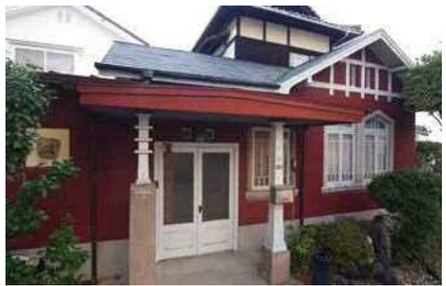
雨宮新七家住宅外観
