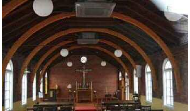
内部の様子。補強材がアーチ状に組み込まれている
