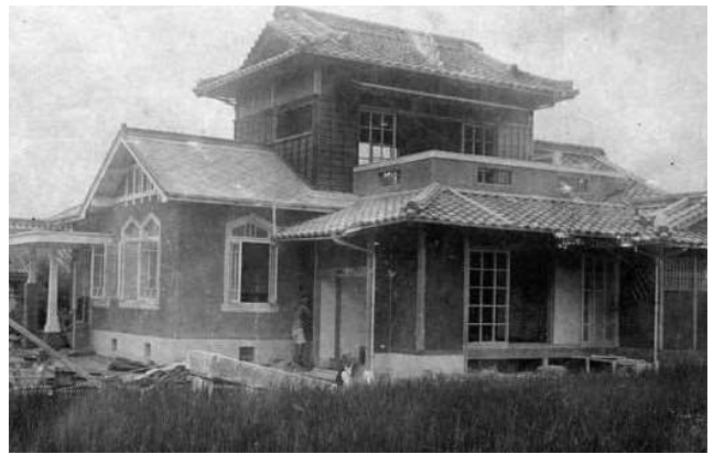
残されている完成間近なころの古写真
