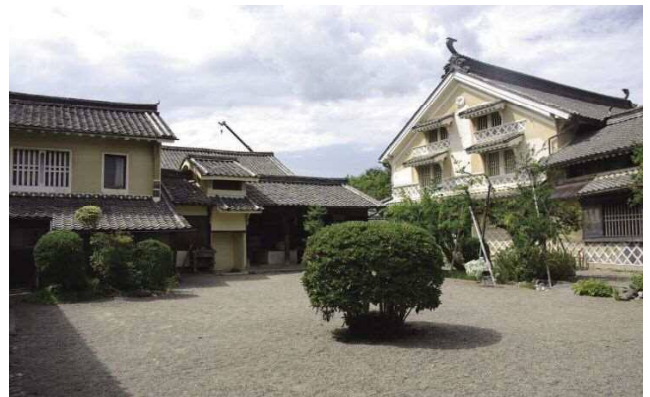
上芳我家 内庭より主屋、釜場、出店倉を見る
