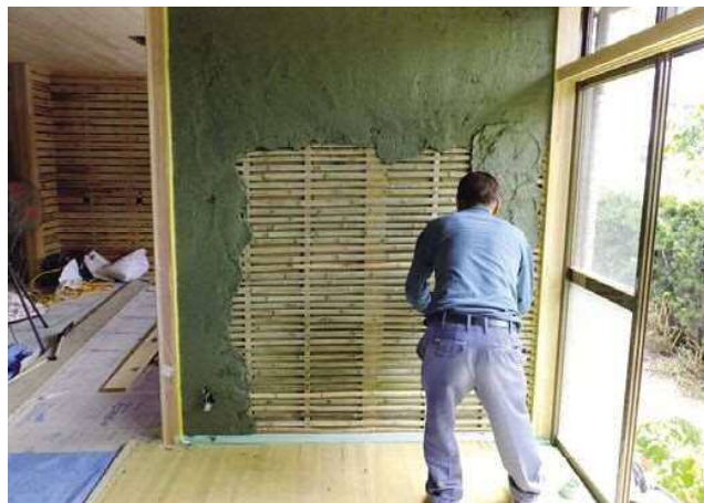
(伝統手法を今に活かし、割竹を下地にして大壁で土壁をつけていく。)
