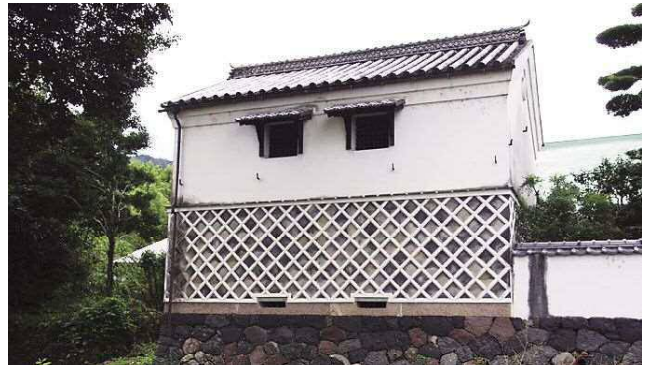
母屋北側の蔵 石垣の上に建つ
