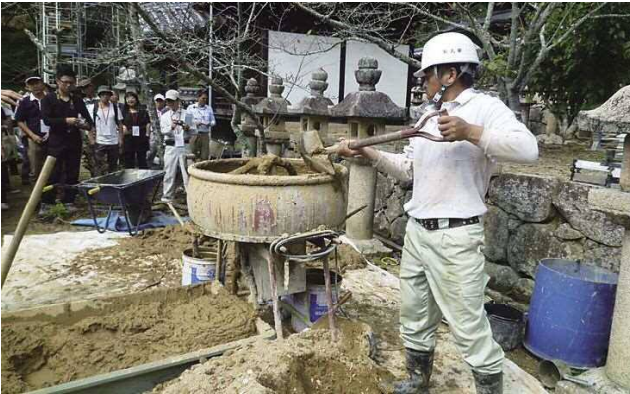
古土と新しい土の混ぜ合わせの様子を見学
