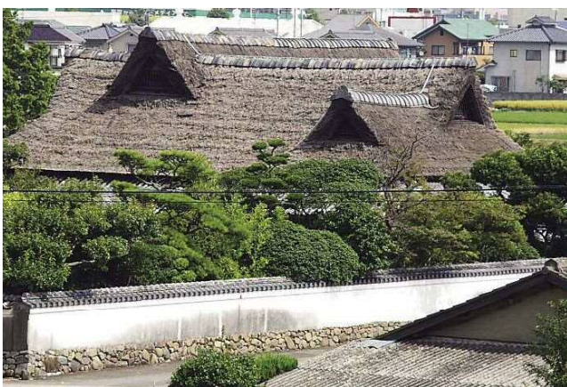
棟が直行しZ型の複雑な屋根
