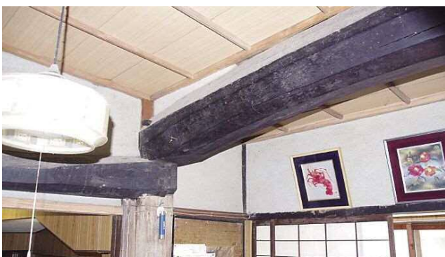
一部見える丸太梁 丁寧に鉋で仕上げられている
