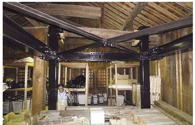
土蔵内の井桁に組まれた補強の鉄骨
