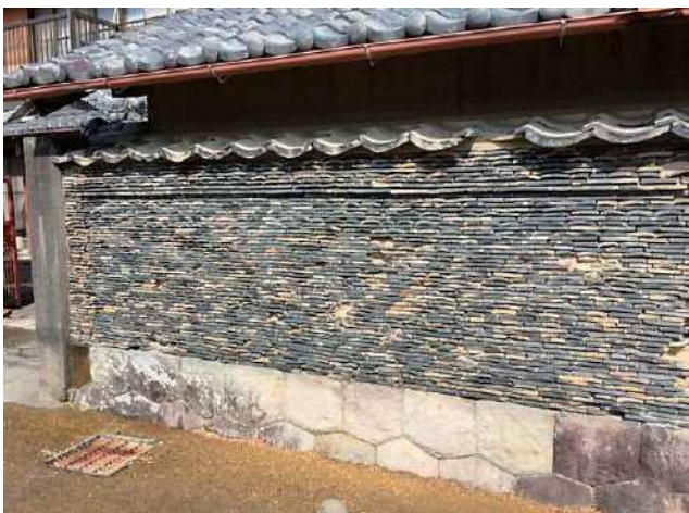
壁一面に瓦が使用されている塀「瓦練塀」
