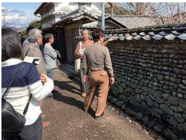
花岡委員長の手のあたりから棧瓦の向きが逆になり、左右対称となっている
