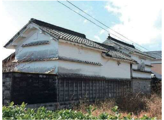
切り妻の壁部分に見られる「水切瓦」
