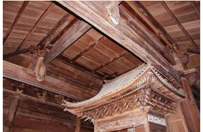
内部の大虹梁と大瓶束 厨子の華麗な屋根が見える
