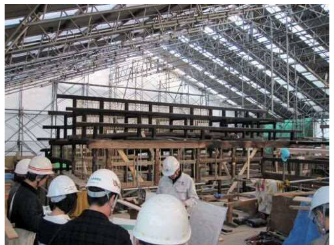
【安岡家「主屋」の保存修理現場見学】
