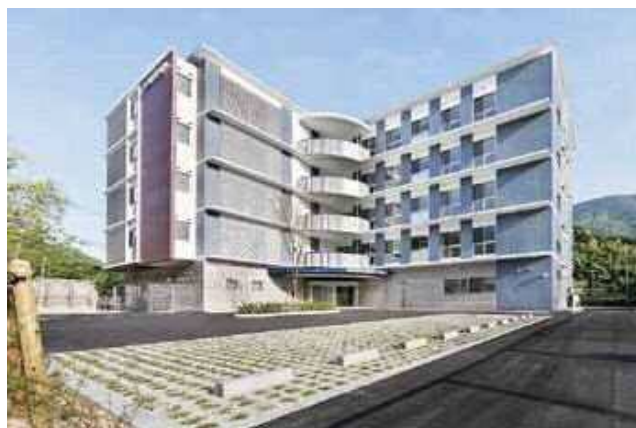
サービス付高齢者向住宅サファイア新築工事
