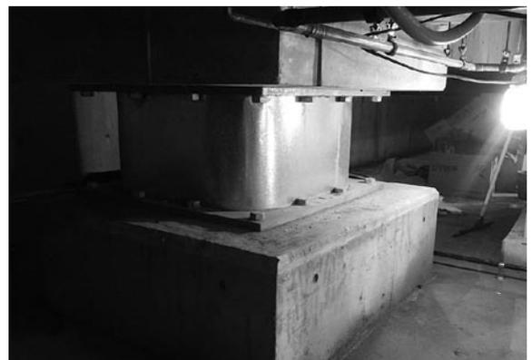
鉄板で保護された免震装置（鉄板は工事完了後に撤
