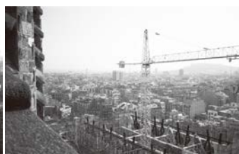
サグラダ・ファミリア工事中2
