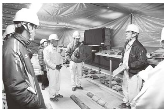
瓦の形状を調べ、一度並べてから屋根に上げる
