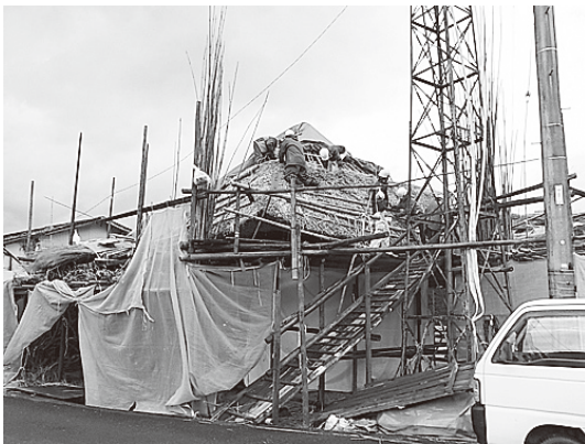
松の窪堂の改修工事の様子
