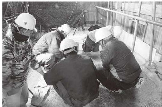
三和土の作業状況の見学
